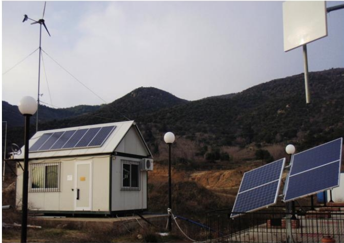
Πρότυπος αυτόνομος οικίσκος παραγωγής ενέργειας ZED-KIM (Σταθερά & Περιστρεφόμενα Φωτοβολταϊκά, Ανεμογεννήτρια)
